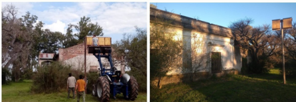
Colocación de un refugio (izquierda) y refugio instalado (derecha). Fotografías: Archivo Reserva Municipal "Las Piedras"
